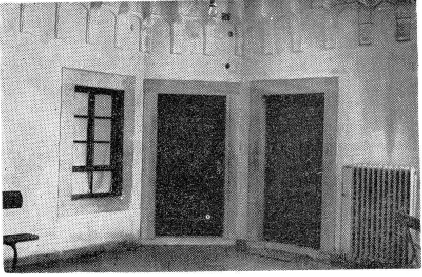
Resim 12. Mekânlara açılan kubbeli mekânın içten görünüşü ve kubbeye intikali sağlayan mukarnas sıraları.
