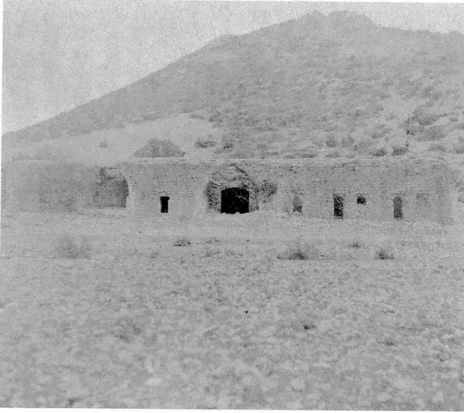
Res. 11 — Diyarbakır Lice İlçesi Çeper Köyü Kervansaray'ının dış görünüşü
