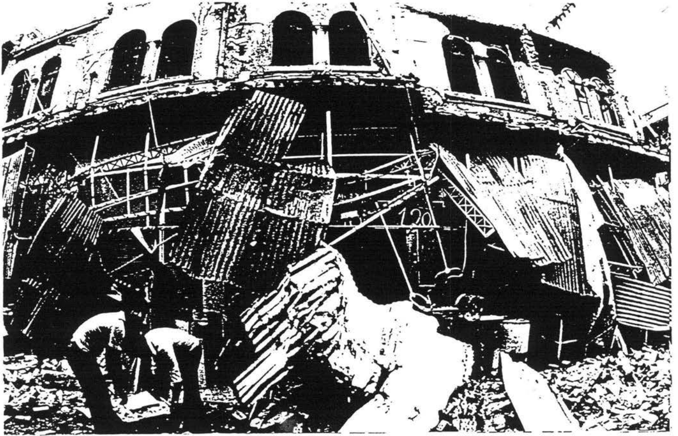
(Resim 10) - Selanik - Hal kompleksi - Deprem Sonrası görünüşü
