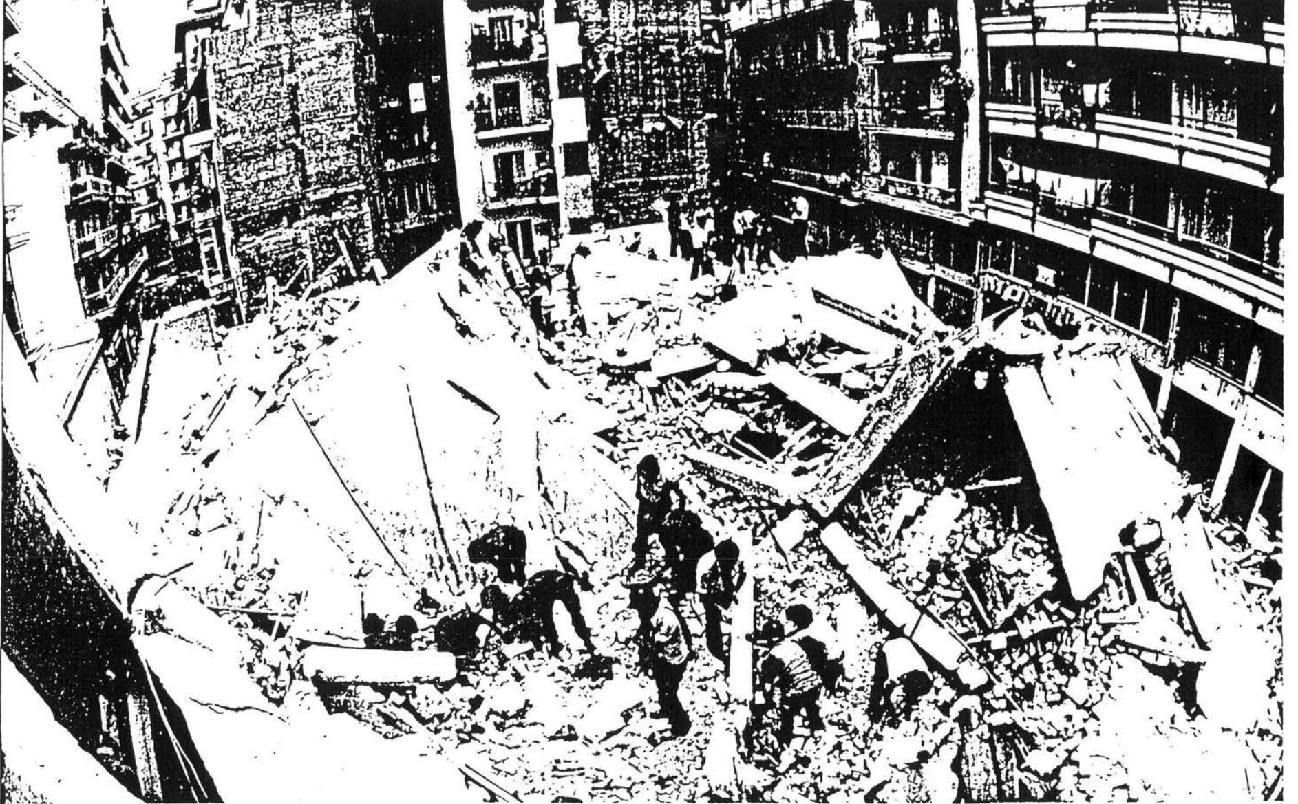
(Resim 9) - Selanik depremindede can kaybına neden olan betonarme - karkas çok katlı yapının deprem sonrası görünüşü
