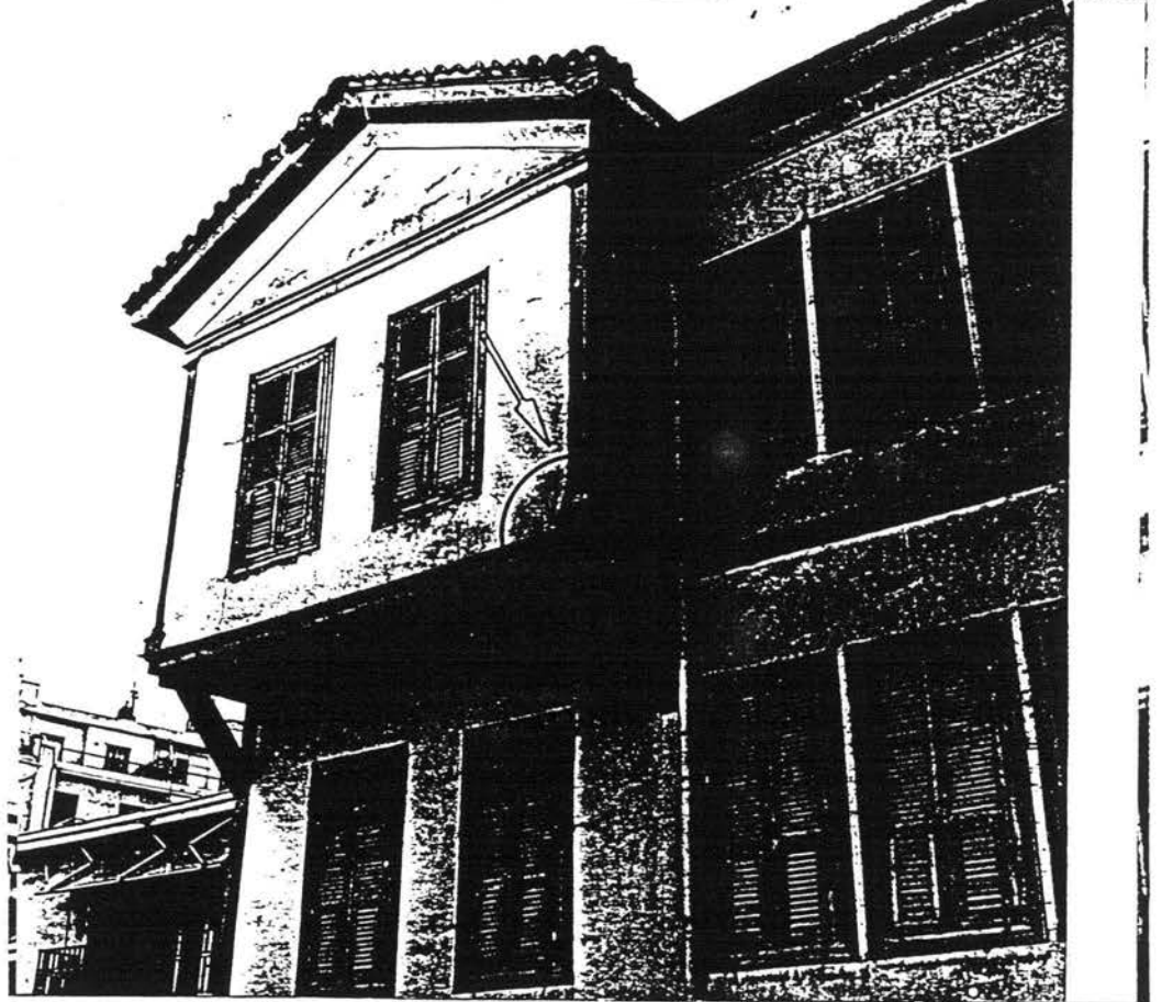
(Resim 27) - Atatürk Evi - Zemin katta-Ahşap Silmede ayrılma (Resim 28-29) Deprem Sonrası Yol cephesi görünüşleri
