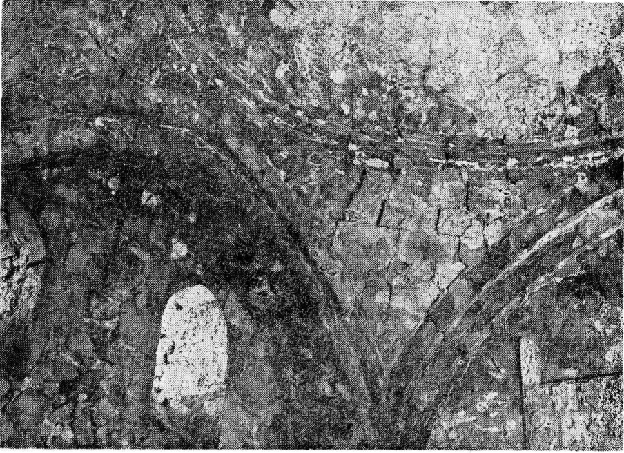
Res. 4- Mihrab önündeki kubbenin pandantiflerinden biri Pl. 4- L'un des pendants de la coupole devant le mihrab.
