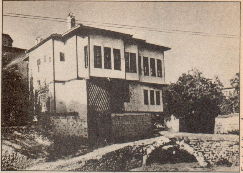
Safranbolu'da kurtarılan bir yapı
