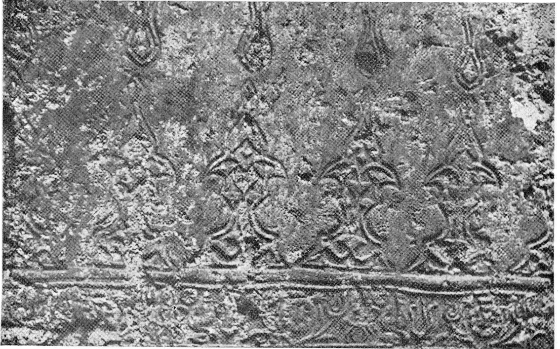
Resim 9 — Köşe halvetinde duvar sıvaları üzerindeki kalıp basma süsleme
