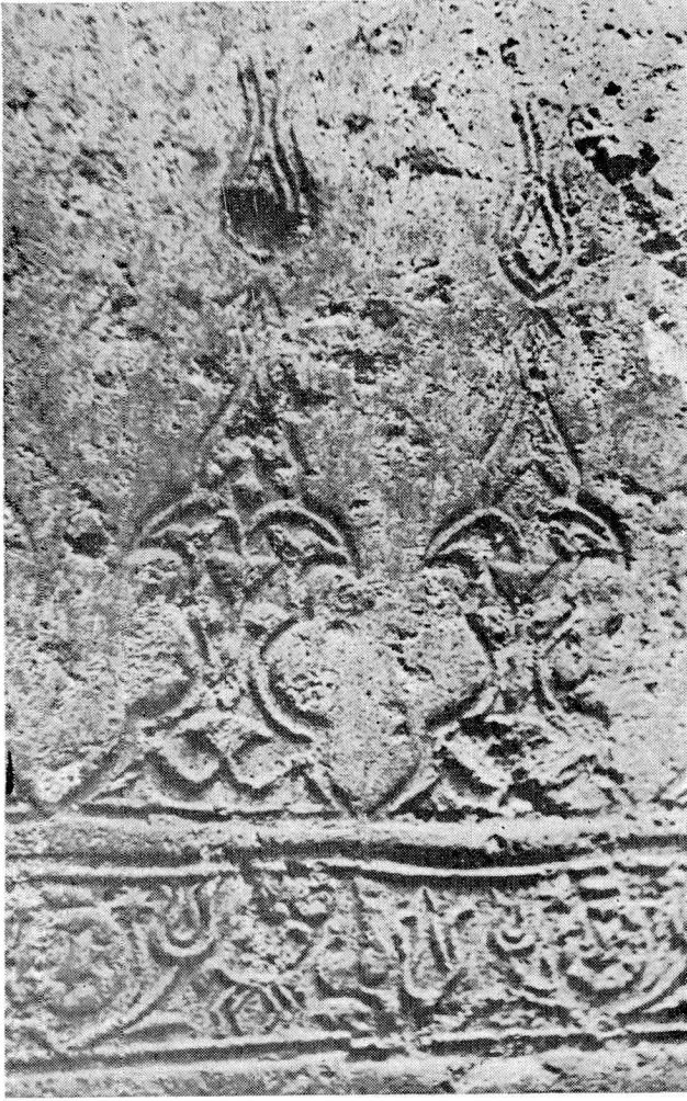
Resim 10 — Köşe halvetinde duvar sıvaları üzerindeki kalıp basma süsleme
