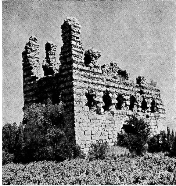
Res. 1 b — Kasaba tarafındaki cephe.
