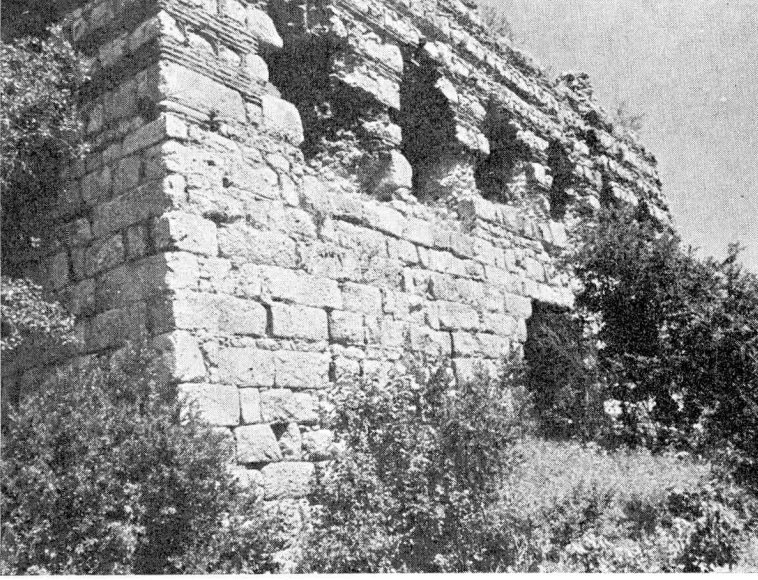
Res. 2 — Binanın kaide kısmı, solyukarı köşede tuğla tezyinatlı ufak saha görülmektedir.
