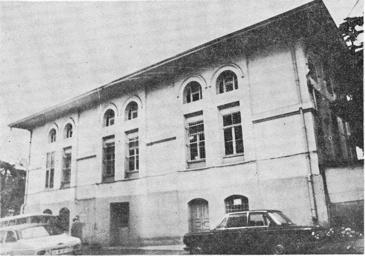
Resim 3. Yapının arka cephesi
