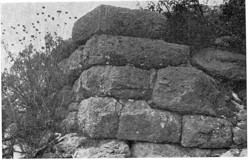
Res. 43 — Hisar içi tepesindeki duvarlardan bir kısım
