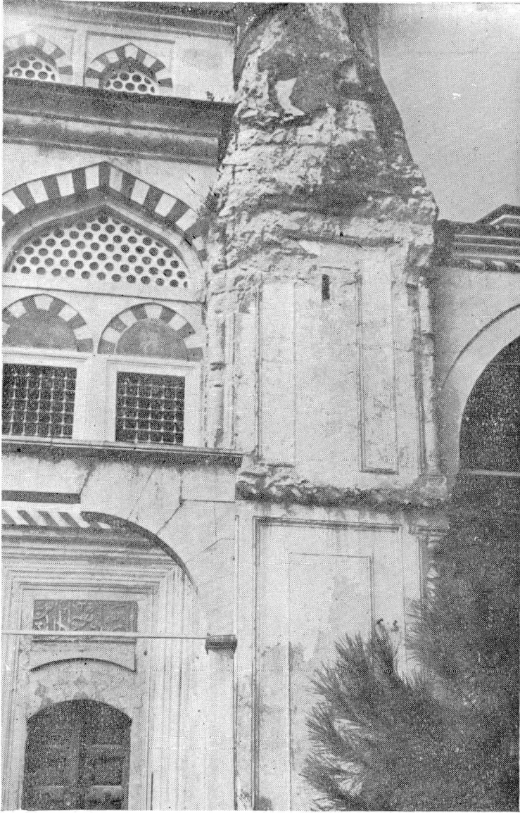
Resim 7 — Muradiye Camiinin minare pabuçu (Onarımdan önce)
