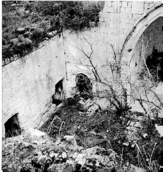
Res. 27 Ahmet Gazi medresesi : iç avlunun batı ve kuzey cepheleri ile ayazlık kısmı Inner courtyard of the madrasa: northwest corner and view of the upper terrace
