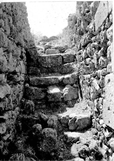
Res. 30 Ayazlığa çıkan merdivenler Stairway leading to the upper terrace
