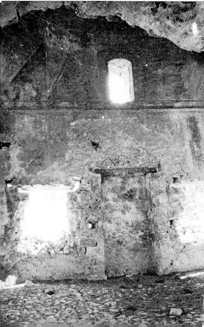
Res. 60 Yelli cami: ibadet kısmının içten görünüşü Yelli mosque: interior view of the sanctuary
