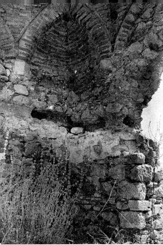
Resim. 47 «A» türbesinde duvar konstrüksiyonu ve kubbe, geçişi Mausoleum «A»: wall construction and transition zone
