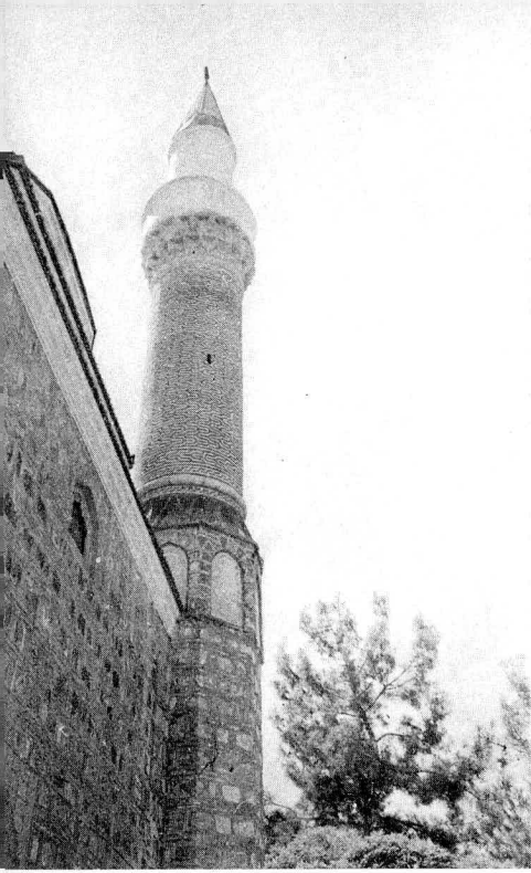
Res. 70 Turgut: İlyas bey camii minaresi ve kuzey duvarı inşaat özellikleri Turgut, İlyas bey mosque: minaret and construction of the north wall
