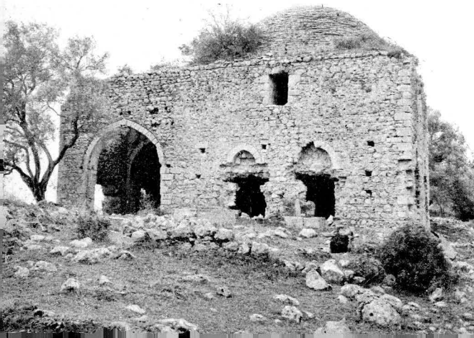
Res. 54 Kepez mevkiinde Yelli Camii: kuzeydoğudan görünüşü Yelli mosque at Kepez near Peçin: view from the northeast
