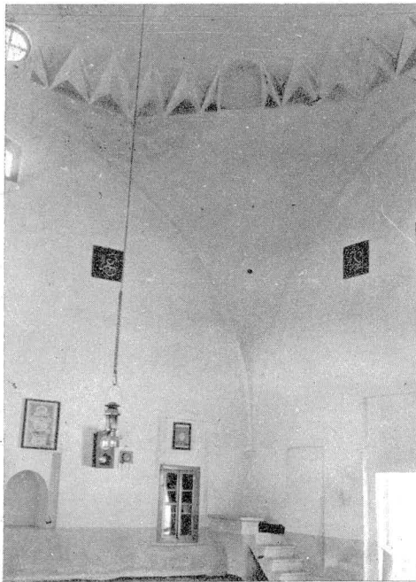
Res. 68 Turgut, İlyas bey camii: İbadet kısmında kubbe geçiş sistemi ve kible duvarındaki örülü kapı Turgut, İlyas bey mosque: transition zone of the sanctuary dome, and walled doorleft of the mihrab
