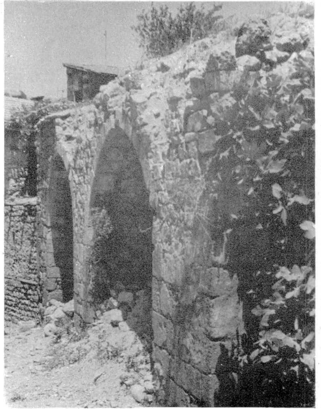
Resim : 22 — Maraş İklim Hatun Mescid - Türbe Kompleksi/Dış görünüm. (Onarım öncesi, 1966).
