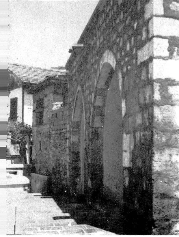
Resim : 23 — Maraş İklime Hatun Mescid - Türbe Kompleksi/Dış görünüm. Onarım sonrası, (Foto; E. Madran)
