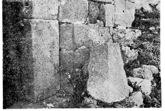
Foto 21 — Giriş kapısının sağ tarafı (Profilli kapı çerçevesi başlangıcı, söve ve kemer taşı)
