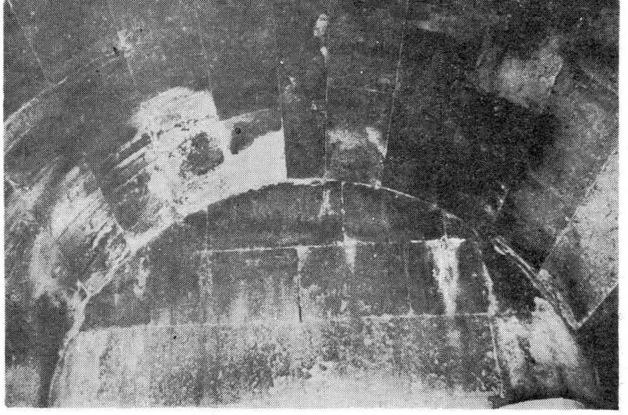
Foto 9 — Sakal Tutan Köyü, Mithat Dede Türbesi, iç kısmın görünüşü (Tonoz)
