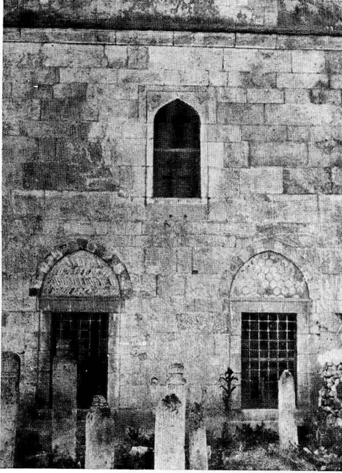
Resim 16 - Husrev Paşa camii yan cephe detayı
