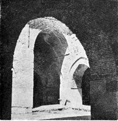
Resim 13. Batı eyvanı onarımdan sonra (M.S.)
