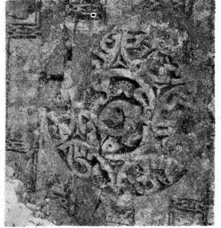
Resim 18. Derzli tuğla zemin üzerine, ştuk rozet. Y. Demiriz.
