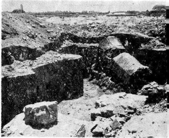
Resim 4. Güney-doğu köşesinde tuğla payenin durumu.
