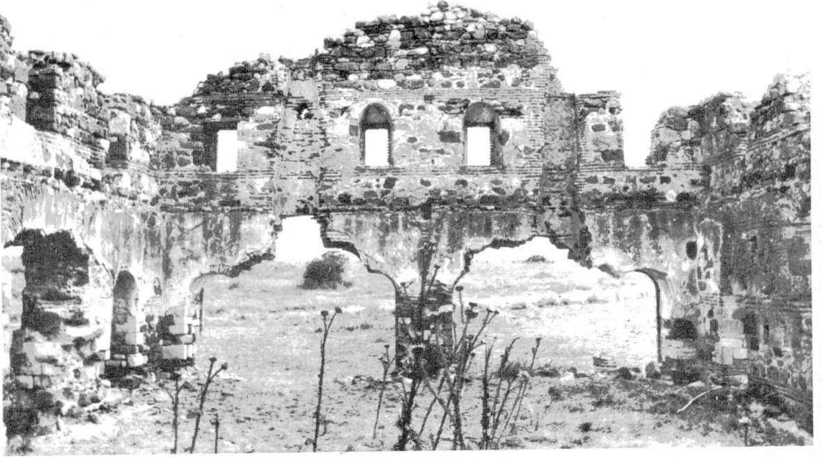
RESİM: 4 Ocakların yer aldığı doğu duvarı.
