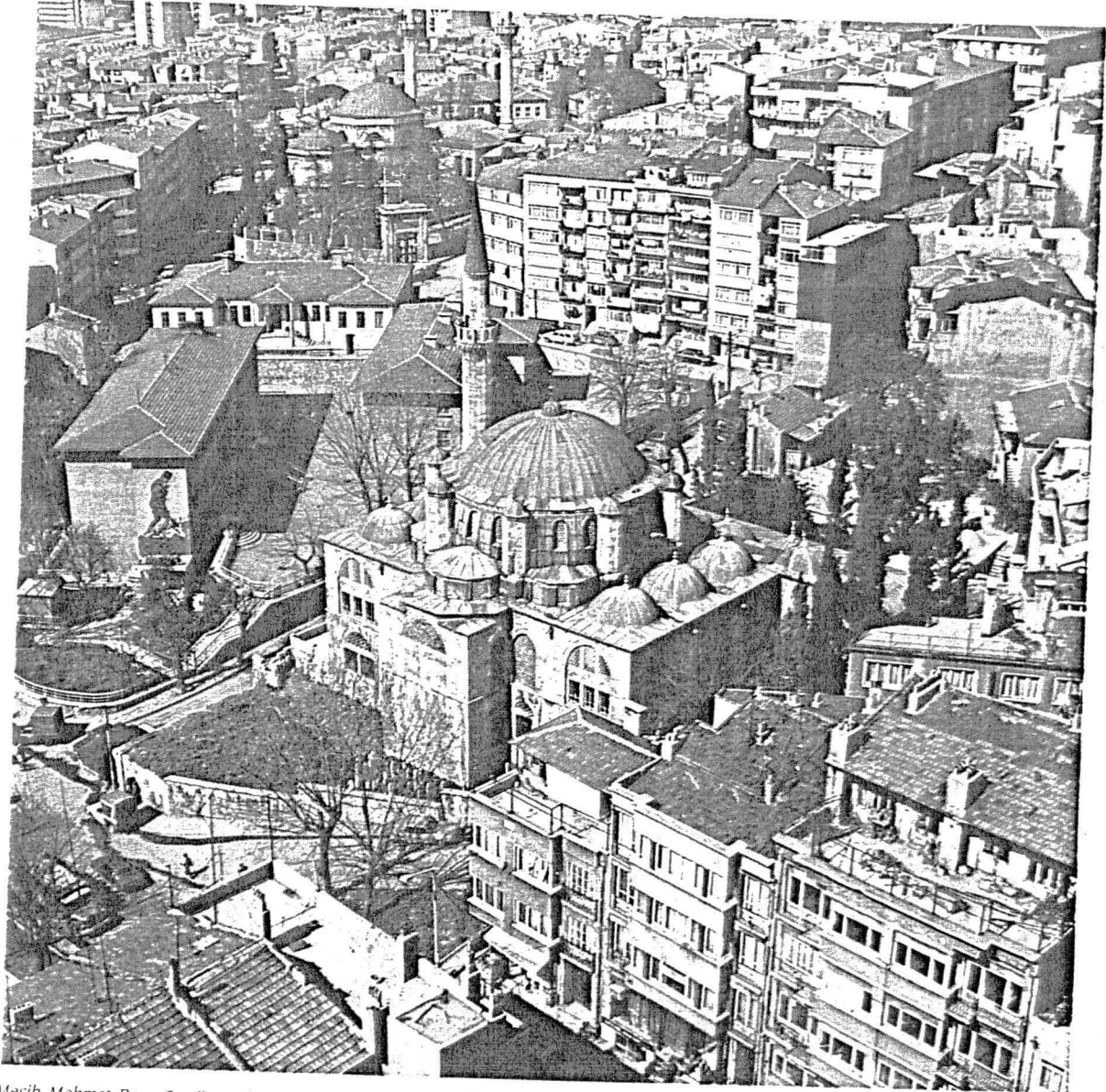
Mesih Mehmet Paşa Camii genel görünümü
