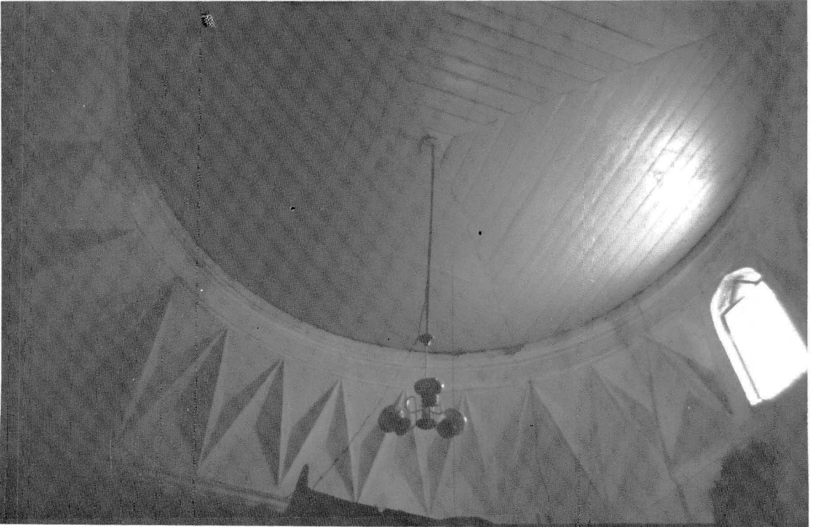
Resim: 6- Dânişmend Gâzi Türbesi kubbeye geçiş sistemi
