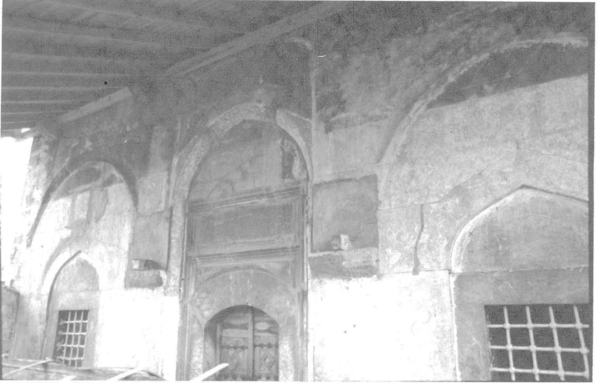
Resim: 3- Melik Dânişmend Gâzi Türbesi'nin kuzey cephesi
