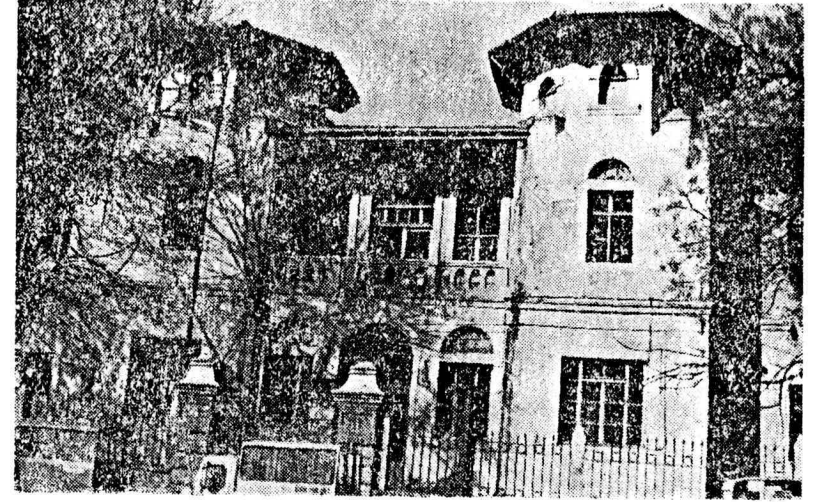
Resim 13. Yangından önce giriş cephesinden ayrıntı.
