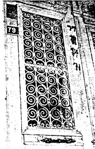
Şekil 45. Serriceli Osman Anadolu Evi Birinci Kat Penceresi Demir Şebekelerinden Ayrıntı.
