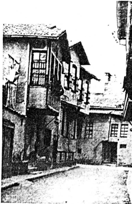
Şekil 40. Serticelli Osman Anadolu Evinin Doğu Cephesi Görüşü.
