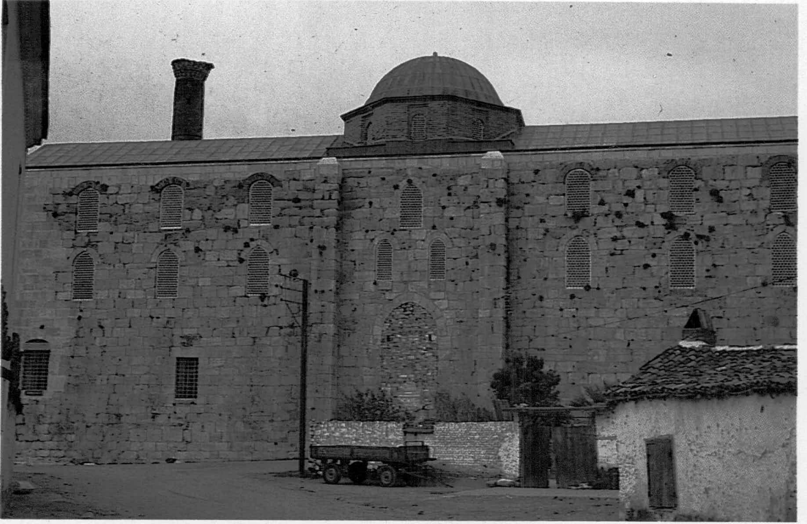
Resim 8- Efes, Selçuk İsa Bey Camii, güney cephe (1978).
