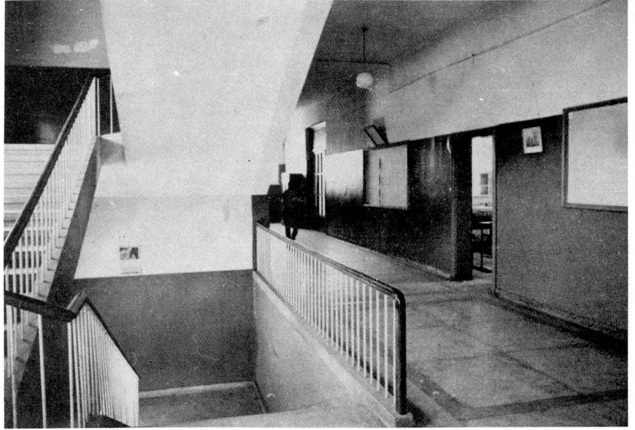
Şekil 13. Cebeci Orta Okulu, içeriden görünüş.
