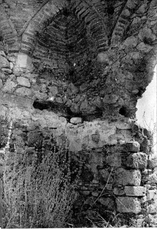
Resim. 47 «A» türbesinde duvar konstrüksiyonu ve kubbe geçişi Mausoleum «A»: wall construction and transition zone
