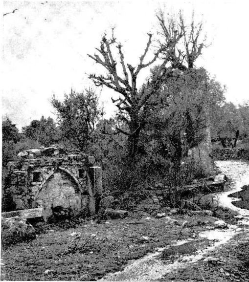
Res. 11 Kaleden şehrin içine giden yol başında bir çeşme yıkısı Remains of a fountain on the path leading to the town
