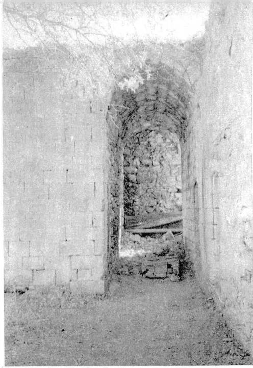
Res. 29 Merdivenlere götüren dehliz (doğu cephesi) Passageway leading to the stairs
