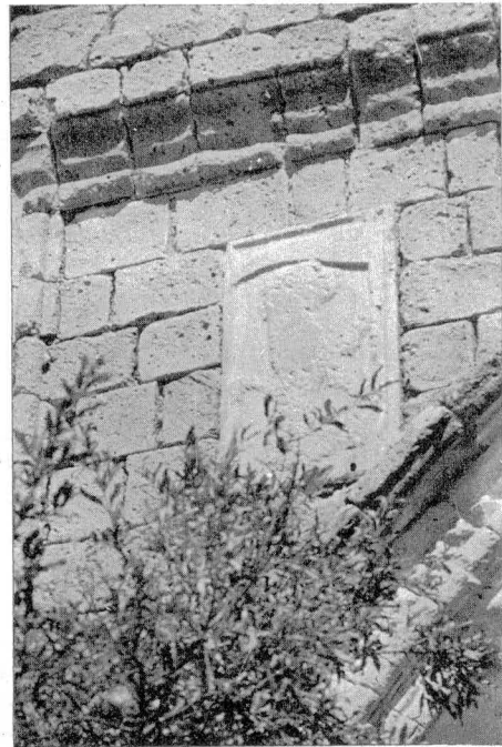
Res. 24 Türbenin giriş cephesinde Ah- met Gazi'nin adını taşıyan arma Armory bearing Ahmet Gazi's name on the main façade of the mausoleum
