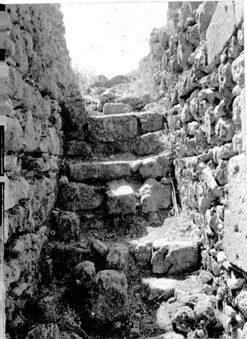
Res. 30 Ayazlığa çıkan merdivenler Stairway leading to the upper terrace
