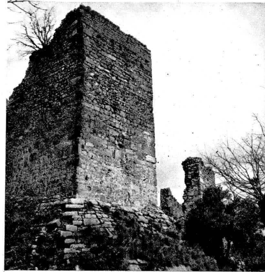
Res. 4 Kalenin müstahkem girişi. Fortified entrance of the castle
