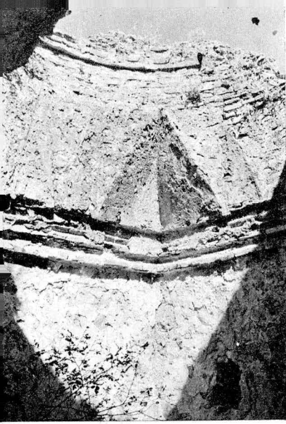
Res. 53 Hamam «B»: Halvet odası kubbe geçişlerinden Hamam «B»: transition zone in one of the bathing cells
