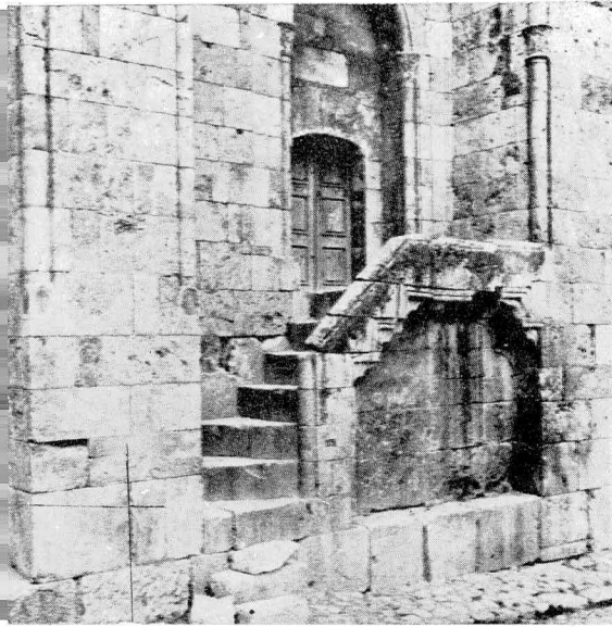
Resim 40. Amasya — Turumtay Türbesi, merdiven kısmı
