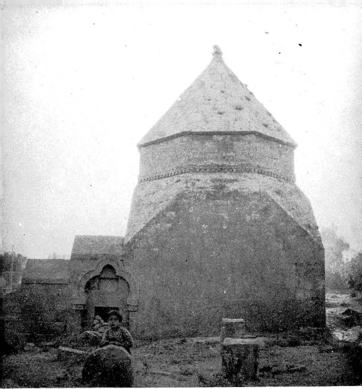
Resim 45. Ablat — Emir Ali Türbesi, yan yan cephesi.
