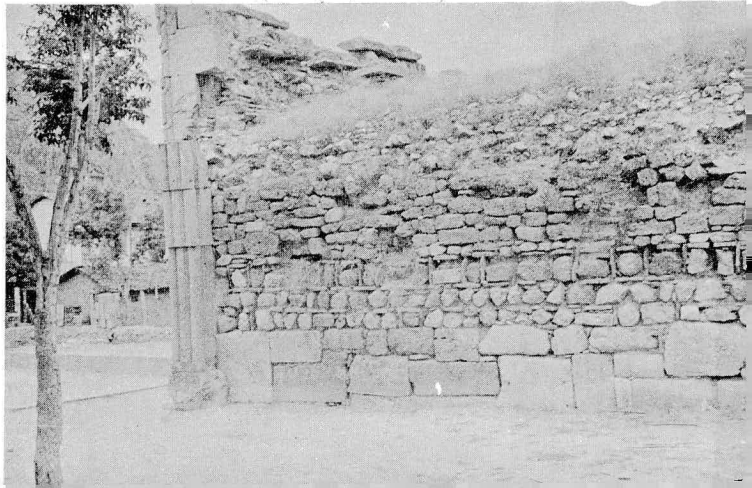
Resim 25. Amasya — Sultan Mesut Türbesi, yan cephe. Amasya — Sultan Mesut Türbe, side view.
